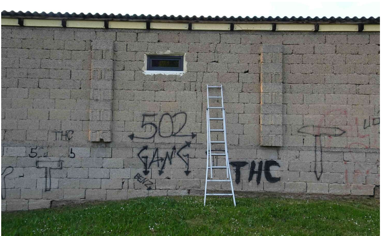
Abb. 4: Nebengebäude im Südwesten des Plangebiets, Ansicht von Süden, über der Leiter ein waagrechter Mauerstich mit Fledermausquartier im Hohlblockstein
