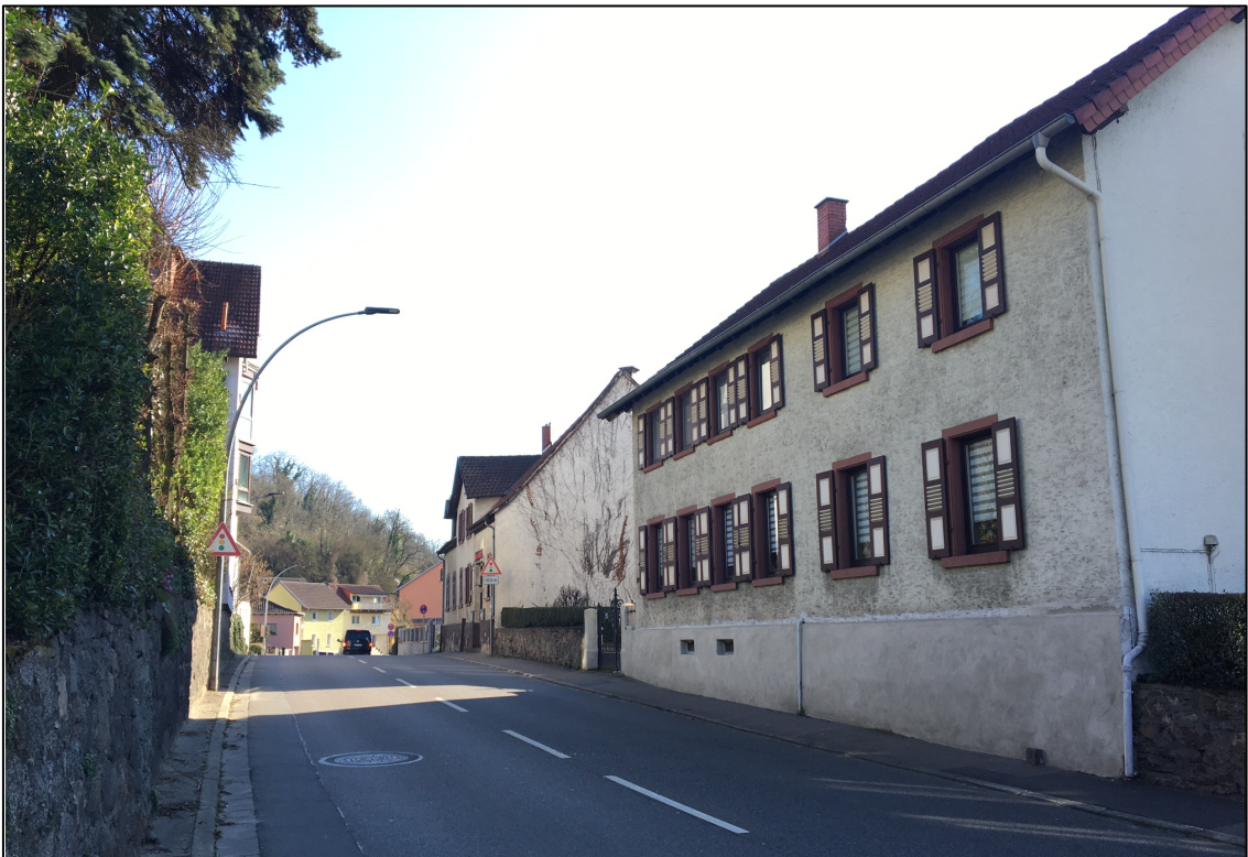
Abb. 8: Landstraße (B 3) Hausnr. 29, Blickrichtung Süd, Planungsbüro Eichler + Schauss, Hemsbach , 02.03.2022
